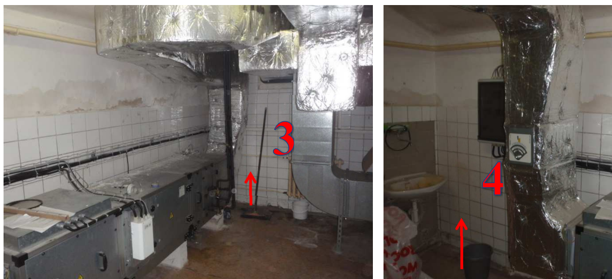
Obr. 9: Místa měření vlhkosti příložným kapacitním vlhkoměrem DM4A
