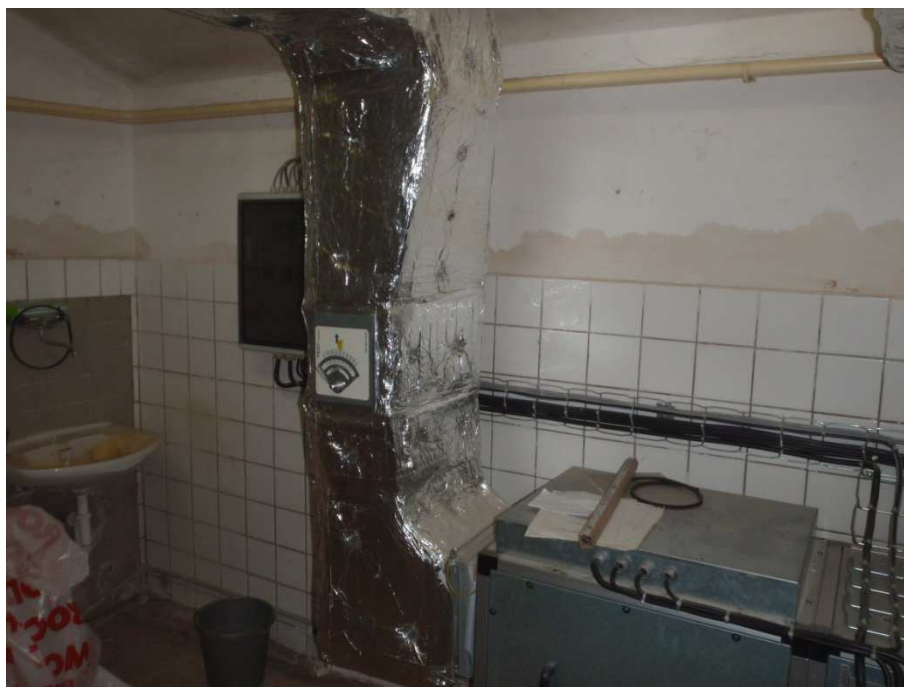
Obr. 5: Vnitřní stěna strojovny vzduchotechniky bez úprav a zásahů (18. 6. 2018)
